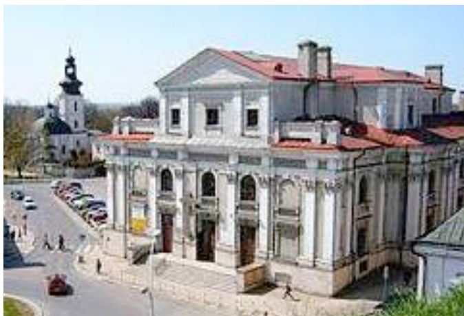
Budynek kościoła przed rozpoczęciem przebudowy
