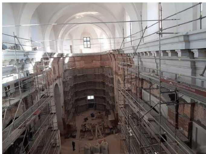
Obecny stan wnętrza odbudowywanego kościoła
