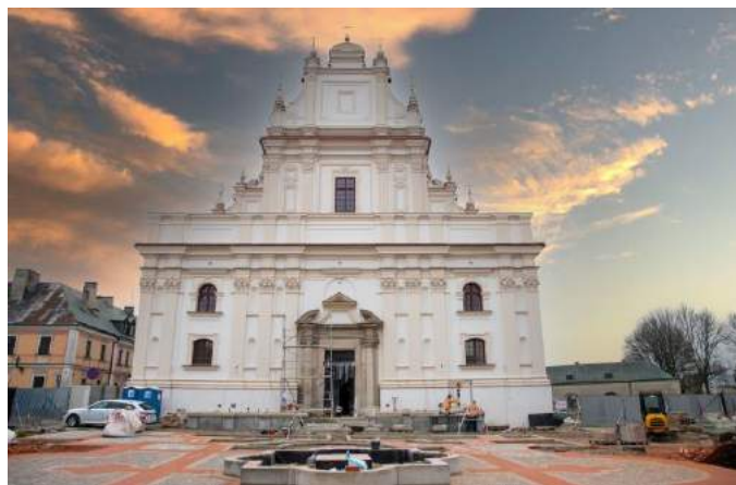
Kościół w trakcie odbudowy
